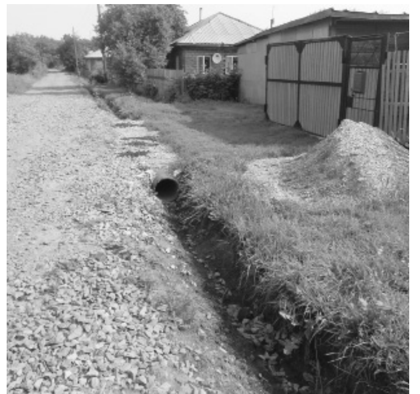
Как и было обещано, зам. главы администрации р.п. Коченёво В. А. Белоусов в июне организовал работы по благоустройству ул. Маяковского.
